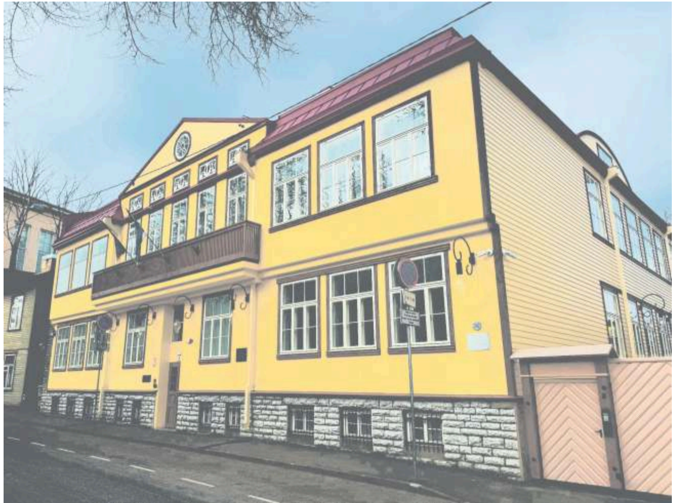
Tallinna Kunstikooli hoone, Kevade 4, mis läbis 2023-2024 põhjaliku renoveerimise.
